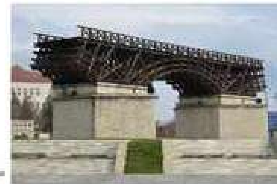
Reconstrucción del Puente de Trajano en Surlia
