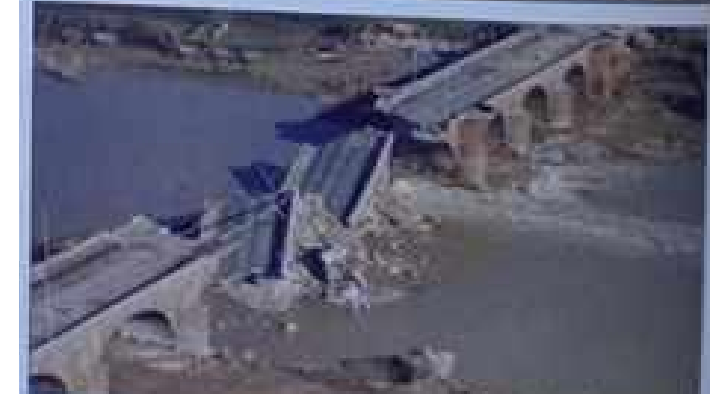
Puente de Molins de Rei Rio Llobregat (Barcelona) 1767 Pilas hundidas: 1971 y 1972
